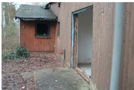
Das Abrissgebäude – Rückseite
