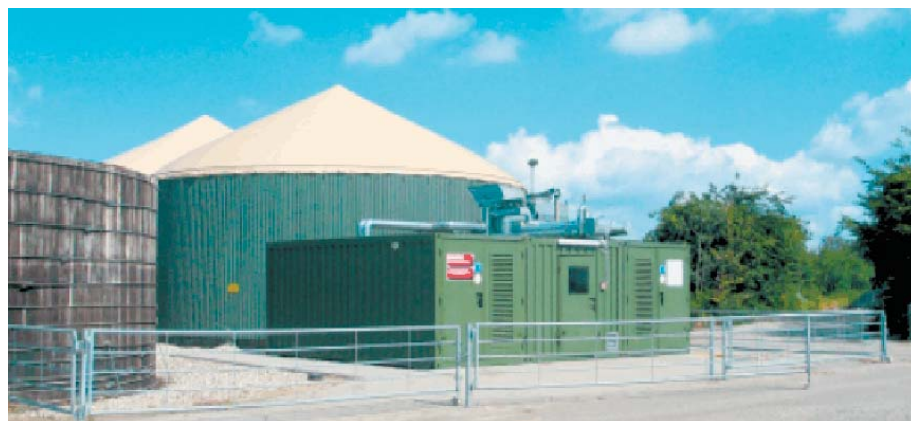
Durchflußbiogasanlage mit integriertem Gasspeicher, Block-Heizkraftwerk-Container und Gärrückstandslager. Bildquelle: Broschüre "Biogas - eine Einführung" von der Fachagentur Nachwachsende Rohstoffe e.V.
