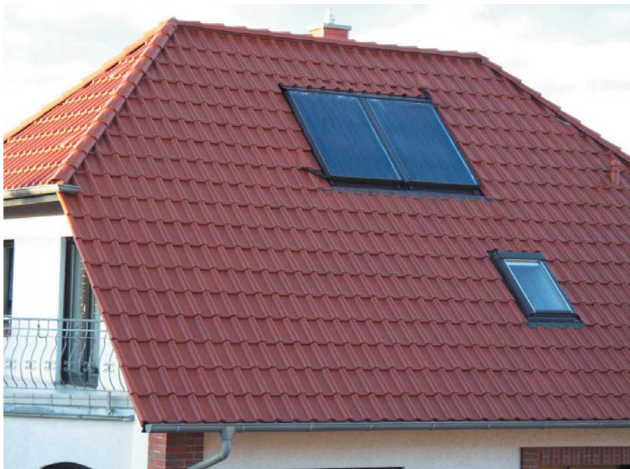
Beispiel einer solarthermischen Anlage
