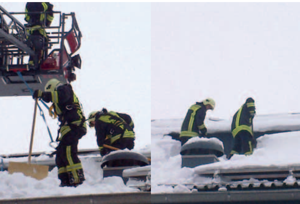
So geht es und so nicht: rechts Einsatzkräfte ungesichert auf einem Dach, links Sicherungsvariante über eine Drehleiter
