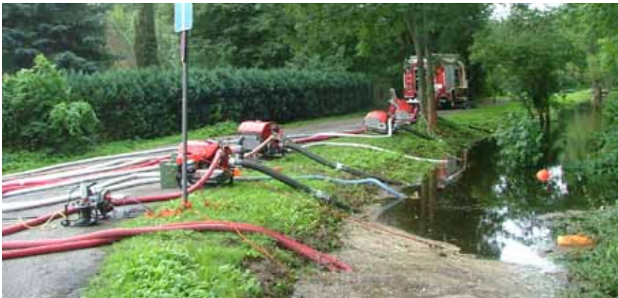
Die Feuerwehr im Einsatz beim Abpumpen einer überfluteten Fläche
