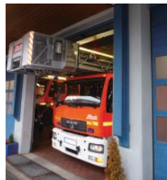
Das Tor ist deutlich zu niedrig für das Fahrzeug.
