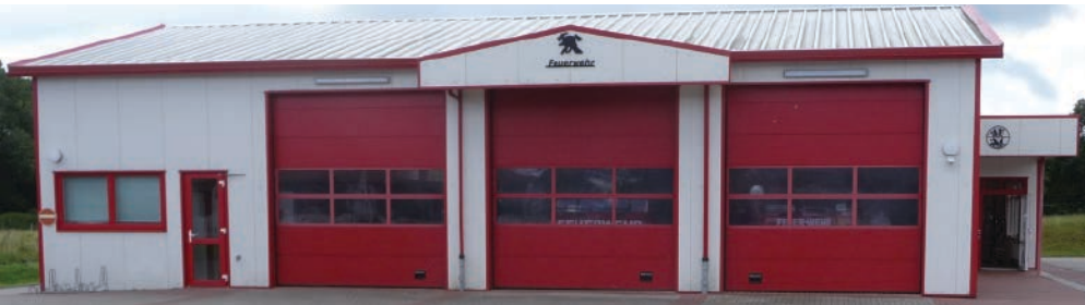
Feuerwehrhaus mit normgerecht dimensionierten Toren
